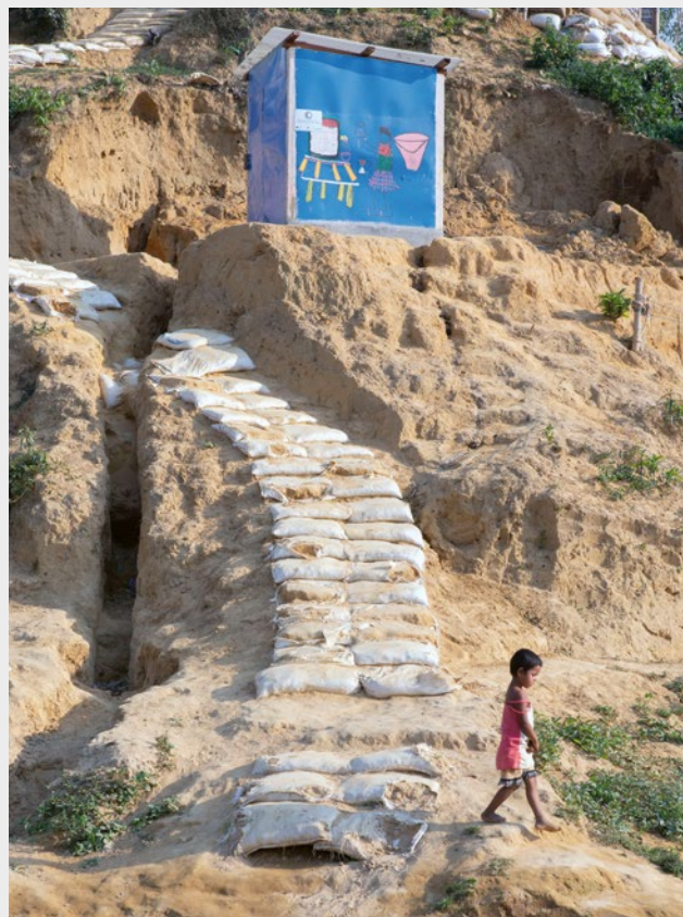
Una letrina en la ladera de una colina en Cox's Bazar, Bangladesh. Se han utilizado sacos de arena para hacer escalones en la colina y para prevenir mayor erosión en un futuro. Las letrinas como estas pueden resultar inaccesibles para las personas que tengan dificultad para subir escalones, incluyendo personas mayores, personas con discapacidad, personas gestantes y niños y niñas pequeños. © Farzana Hossen / British Red Cross
