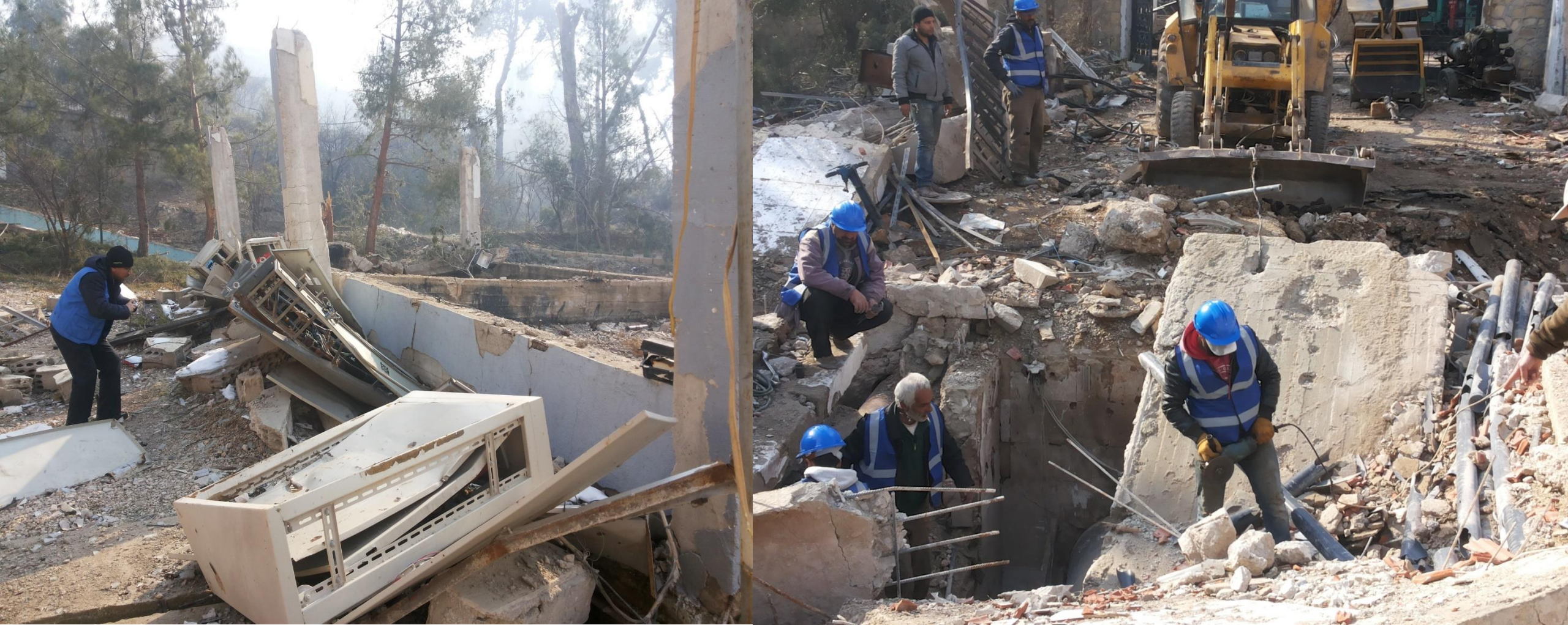
Damages of the main Figeh pumping station building الأضرار في محطة الضخ الرئيسية لنبع الفيحة
