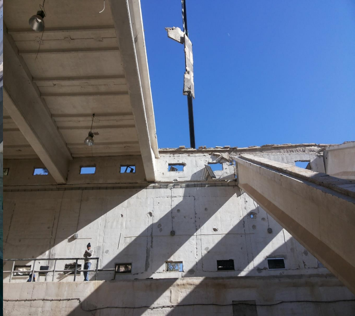
The Fiegh Spring supporting beam after collapse just beside the Roman temple الجسور الحاملة لسقف صالة نبع الفيحة الرئيسية بعد إصابتها وانهارها بجانب المعبد الروماني
