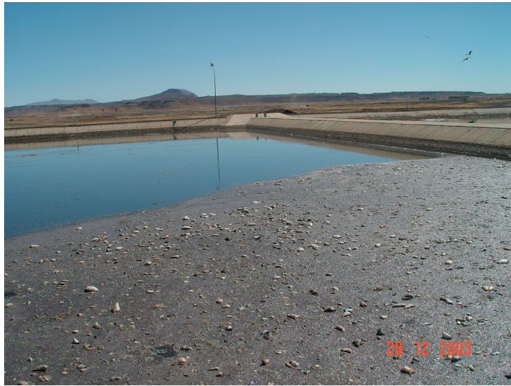
وجود الطبقة الطافيه مؤشر على عدم وجود شبك عند مدخل المحطة
