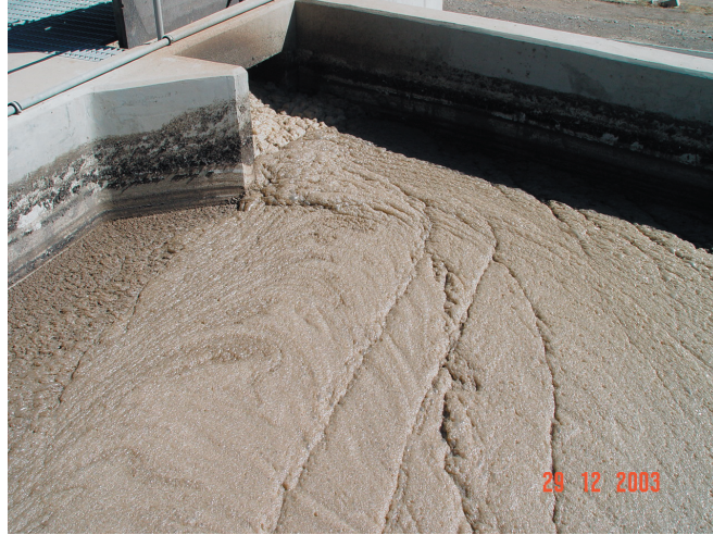
الرغوة الكثيفة الناتجة عن استخدام المنظفات تؤثر سلباً على كفاءة المعالجة
