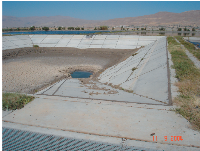
عدم الدك والإختيار غير المناسب للتربه أدى الى تسرب الماء
