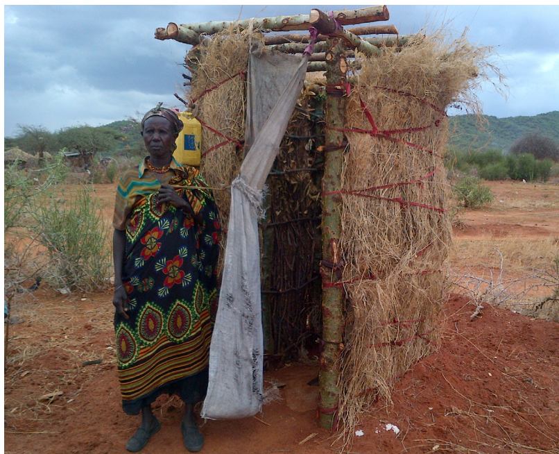
Latrine des ménages construite au niveau locale à Arumrum, dans le district d'Isiolo.
