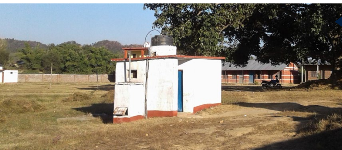
Inodoro escolar Dang adaptado al género con incinerador para residuos menstruales
