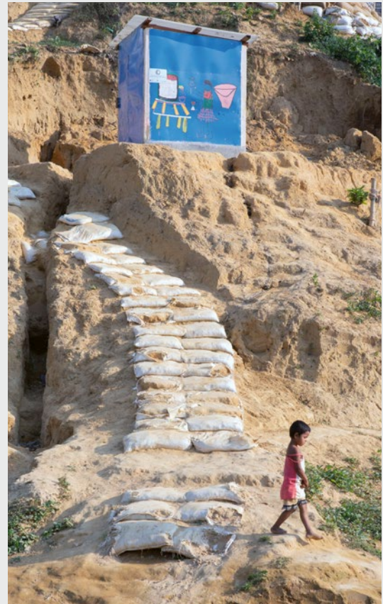
Choo kilicho juu mlimani katika Cox Bazar, Bangladesh. Mifuko iliyojazwa mchanga imetumika kutengeneza njia za kukanyaga kuenda juu mlimani, na kusaidia kuzuia mmomonyoko zaidi. Vyoo kama hivi huenda visiweze kufikiwa na watu ambao wana ugumu wa kukwea juu. ikijumuisha watu wazee, watu wanaoishi na ulemavu, wanawake wajawazito na watoto wadogo. © Farzana Hossen / British Red Cross
