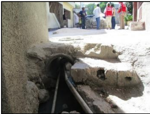
Photo D911_1 : Tuyaux eau dans les conduits
