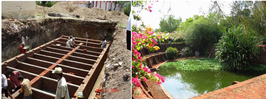
Figure 2 : A gauche - réacteur anaérobie à chicanes DEWATS en construction ; à droite – bassin de polissage DEWATS
